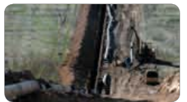
پروژه احداث ایستگاه پمپاژ فاضلاب در شهر گناوه
